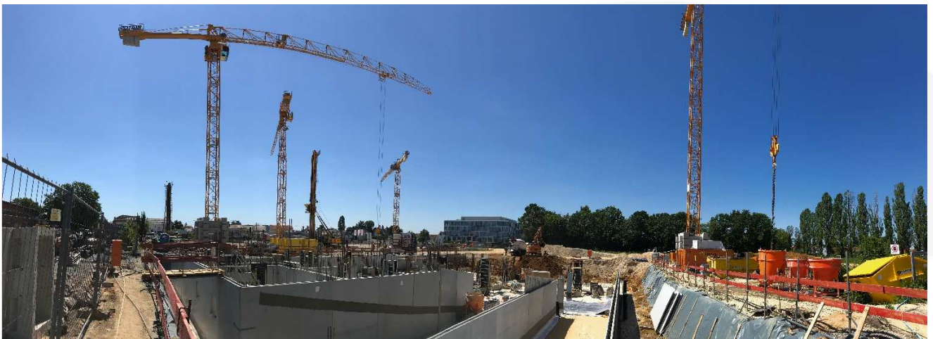
Panoramabild der Baustelle „Hansa-Areal“, Sigmaringer Straße in Stuttgart-Möhringen
