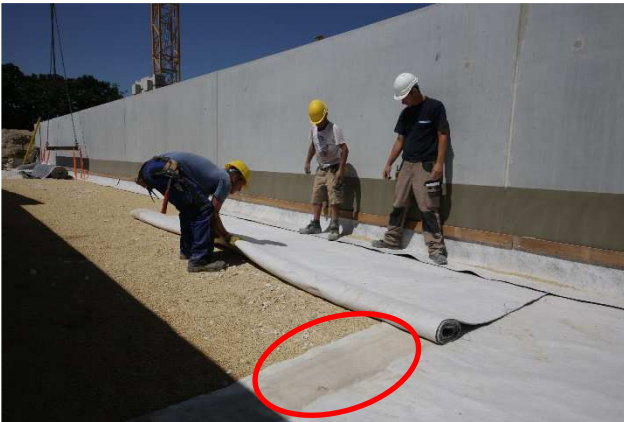
Im Überlappungsbereich Einstreu mit Bentonitpulver, im Bild sichtbar als „bräunlicher Streifen“
