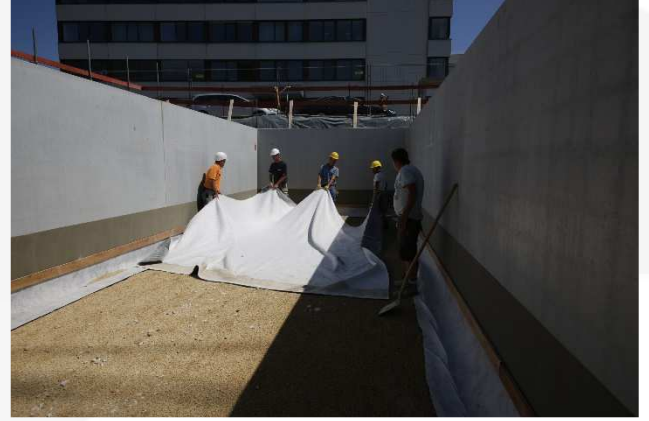
Die Teilstücke der Tondichtungsbahn werden nach dem Zuschneiden händisch verlegt
