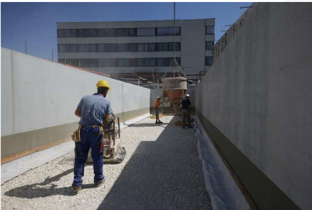
Verdichten der Schottertragschicht und Aufbringen der mineralischen Ausgleichsschicht
