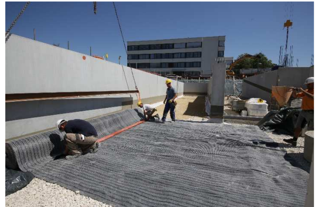
Zuschneiden der Tondichtungsbahn auf das richtige Maß
