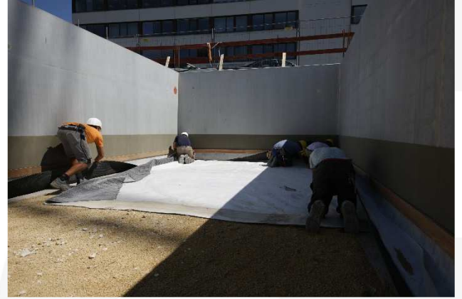
Händische Verlegung: Sorgfältiges einpassen und Herstellung der Überlappungen
